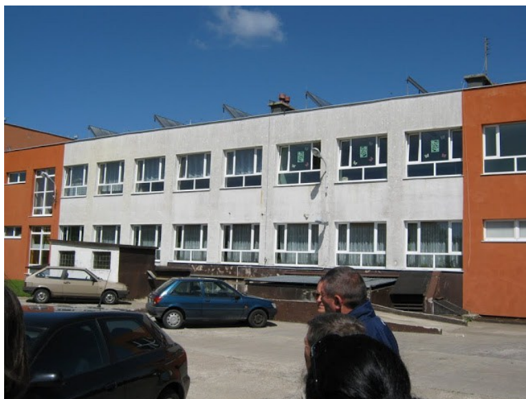
Rys. 89 V kamień milowy – Polska – Gniewino - Instalacja kolektorów słonecznych na dachu szkoły do zaopatrzenia w c.w.u. szkoły i basenu przyszkolonego
